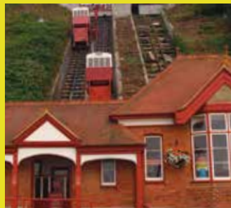
Ascenseur, mû par un mécanisme à eau
